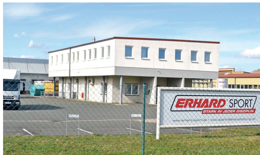
Verwaltungsbau der Erhard Sport heute am neuen Standort Burgbernheim. Foto: mes
